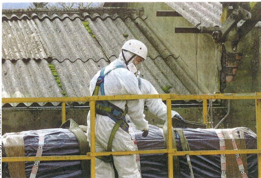
Gefährliche Abfälle wie Eternit sollten Profis direkt entsorgen – bei einer Lagerung riskieren Sie sonst empfindliche Geld- und sogar Freiheitsstrafen.
